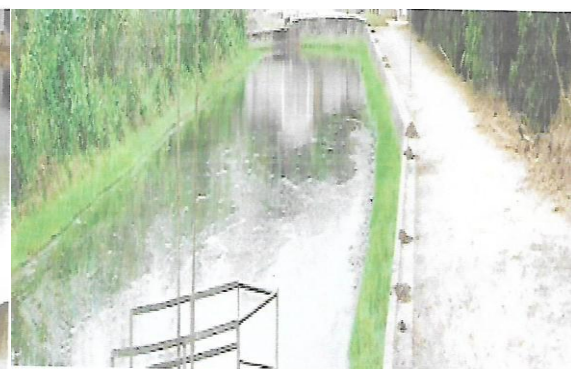
Figure 6: La rivière Kokokoumba en aval à 100m des deuxièmes affluents de rejet Socir
